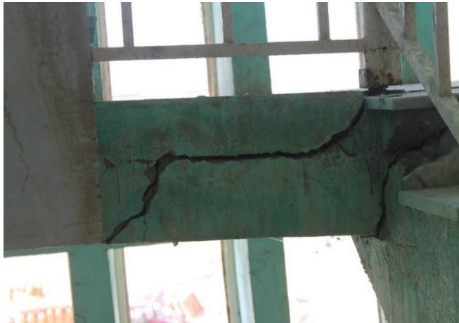
شکل ۳: شکست سلب زینه بلاک C لیلیه‌ی ذکور در قسمت غربی که از اثر عوامل ○ عدم استحکام و سیخ‌بندی سلب چوک زینه عمود به سیخ‌های سلب زینه (شکل ۳).
