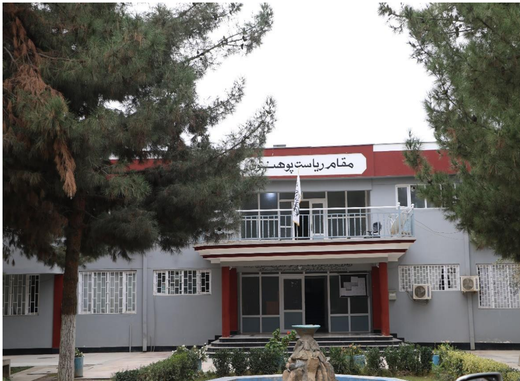
ساختمان اداری پوهنتون تخار
